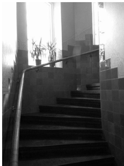
Avsnitt av trapphuset med sitt gulglaserade klyvtegel på väggarna.
