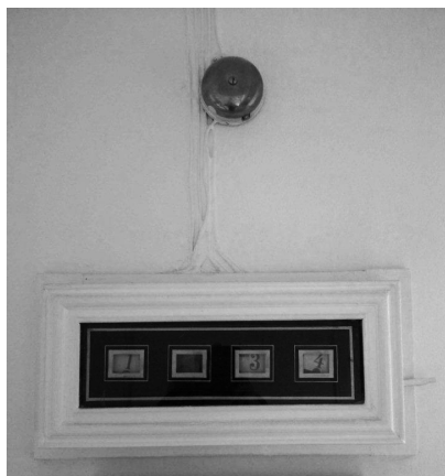
Betjäntklocka på väggen i köket (ursprungligen i klarlackad ek) kopplad till matsal vardagsrum herrum och sängkammare
