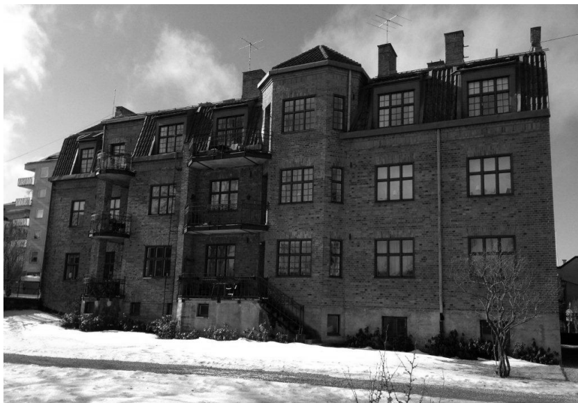
Husets baksida med fasadförskjutning, balkonger, burspråk m.m.
