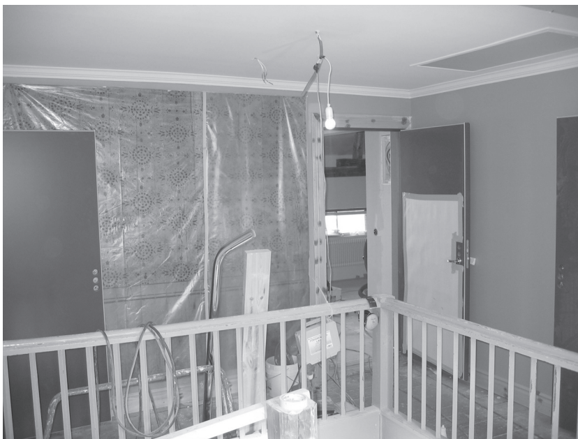
Gamla förrådet har byggts om till bostad. Utsikt från trapphuset.
