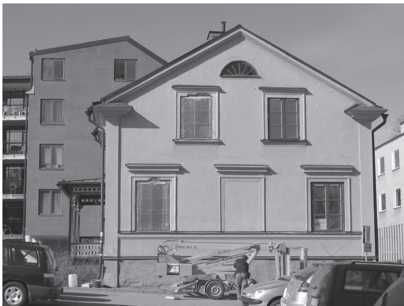
Gula Villans igensatta fönster öppnas åter upp.
