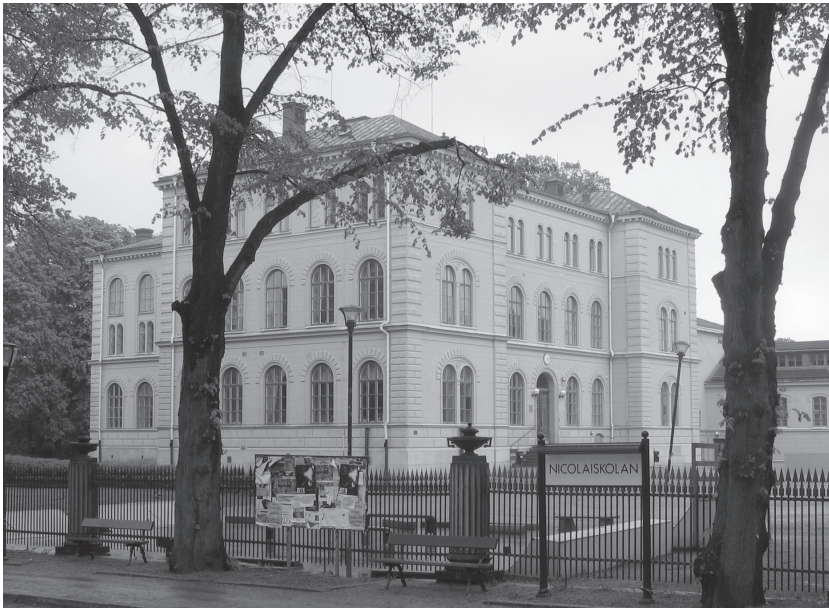
Ån i dag är byggnaden en institution för lärande; högstadieskolan Nicolaiskolan.
