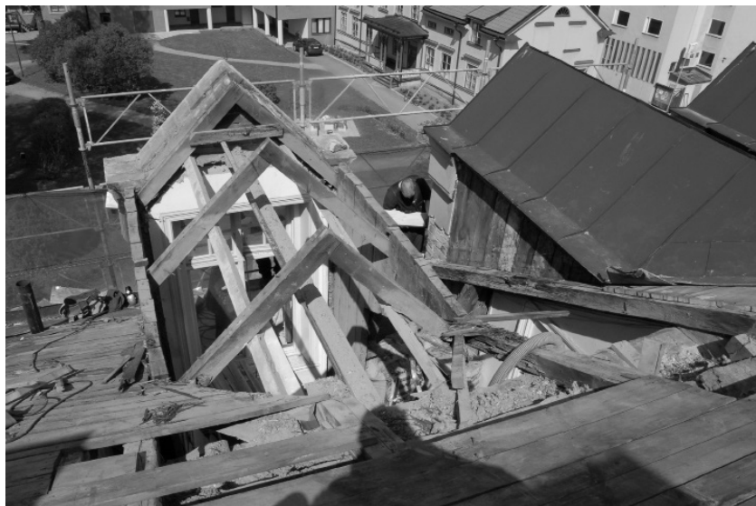
Den bistra vinterns inverkan på nationshusets tak blottade takets sanna natur. Bärande konstruktioner var genomruttna.
