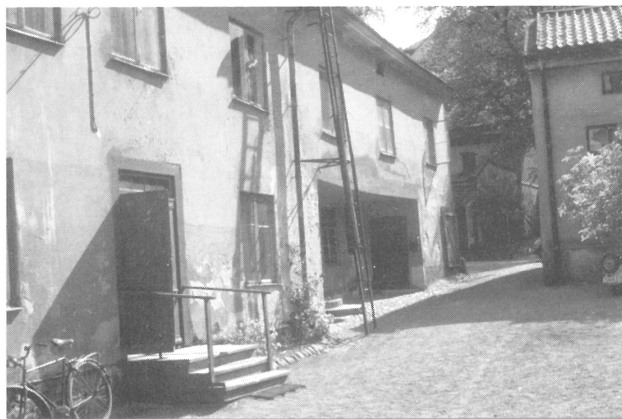
5. Entréfasaden med tydlig prägel av 1800-talets byggnadskonst. Gårdshuset, i vissa handlingar kallat Abdera, skymtar till höger i bilden. Där står en Vespa med numret T 365.
